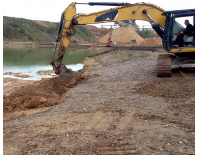
Anlage eines Flachwasserbereichs vom Ufer aus.
