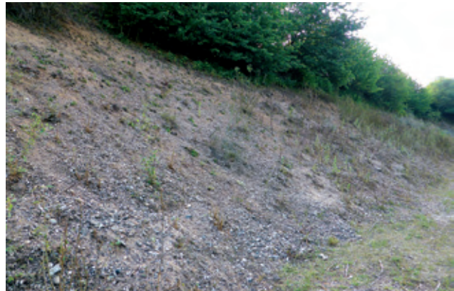
Winterquartier: Böschung nach der Entfernung des Aufwuchses.
