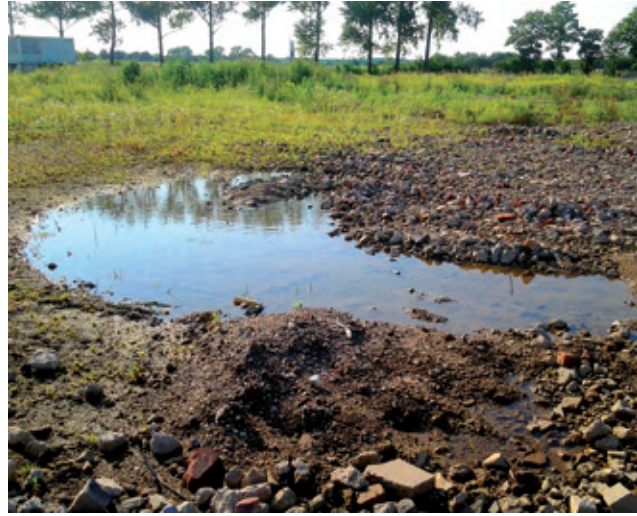
Grober Schotter eignet sich am Besten zur Verfüllung.
