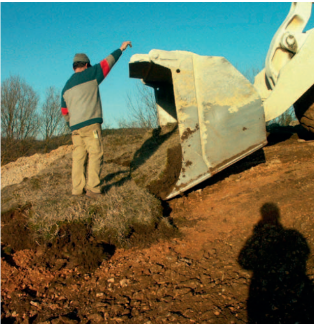
Einbau der Magerrasen-Soden am neuen Standort im westlichen Steinbruchbereich.
